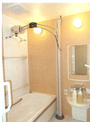
1階小浴槽（可動式手すりと リフト完備）
